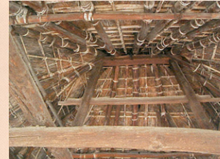
「めんぶく」が出るお堂のはわらぶき屋根だった。上や下や、いろんな角度から見てみると、面白い発見がある。(写真：神野町のお堂)
